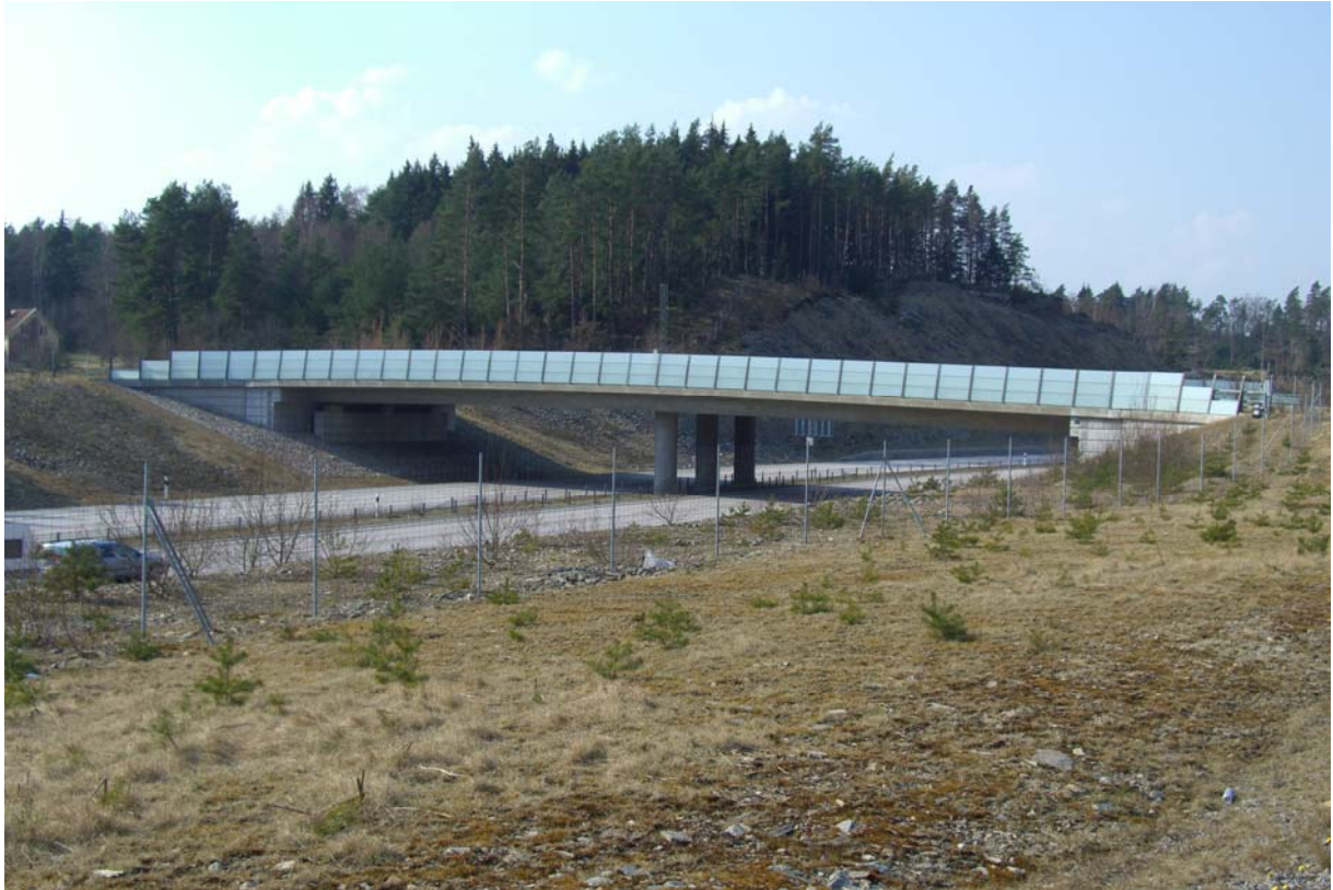
Figur 5 Viltbro över motorväg E6 vid Grytingen
