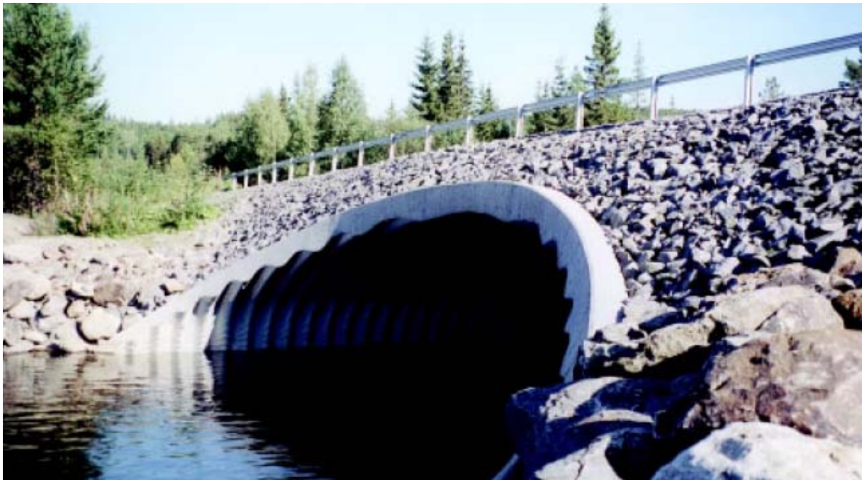
Figur 4 Ändavslutning med kantbalk av betong
