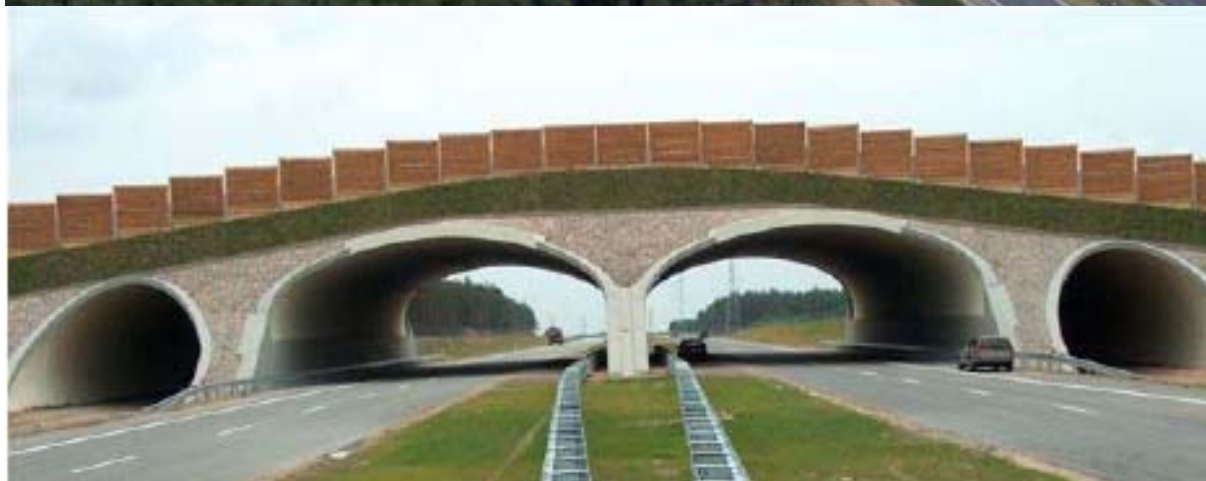
Figur 1 Ekodukt över motorväg A2 i Polen, SuperCor valvbågar
