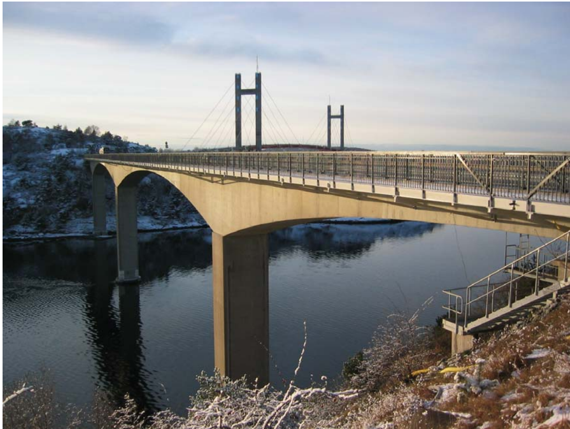
Figur 5.2 Vy över Källösundsbron sedd söderifrån vid Stenungsöns landfäste.
