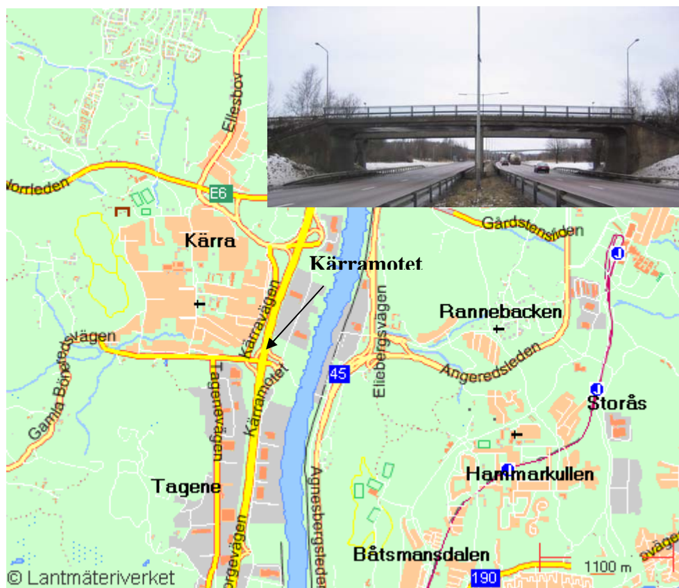
Figur 4.1 Kärramotets geografiska läge och vy av bron från söder, © Eniro Sverige AB.
