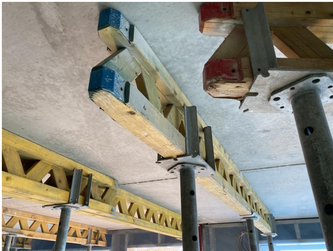
Bild 3. Formbalkar och stämp för platsgjuten betong. (Författarnas egen bild, 2022)
