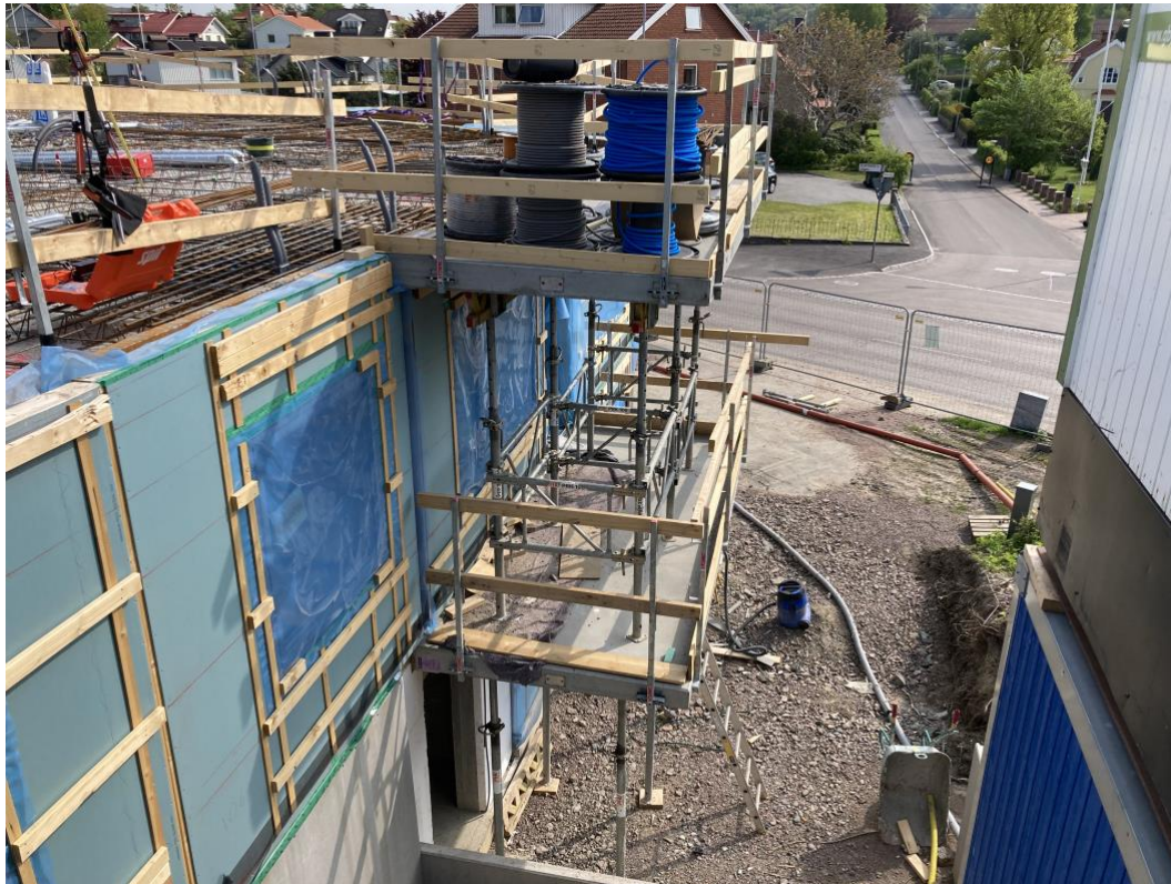
Bild 2. Stödsystem för prefab-balkonger. (Författarnas egen bild, 2022)
