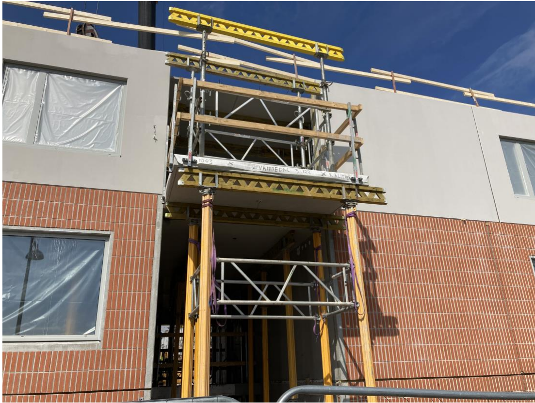
Bild 4. Stödsystem för prefabbalkong. (Författarnas egen bild, 2022)
