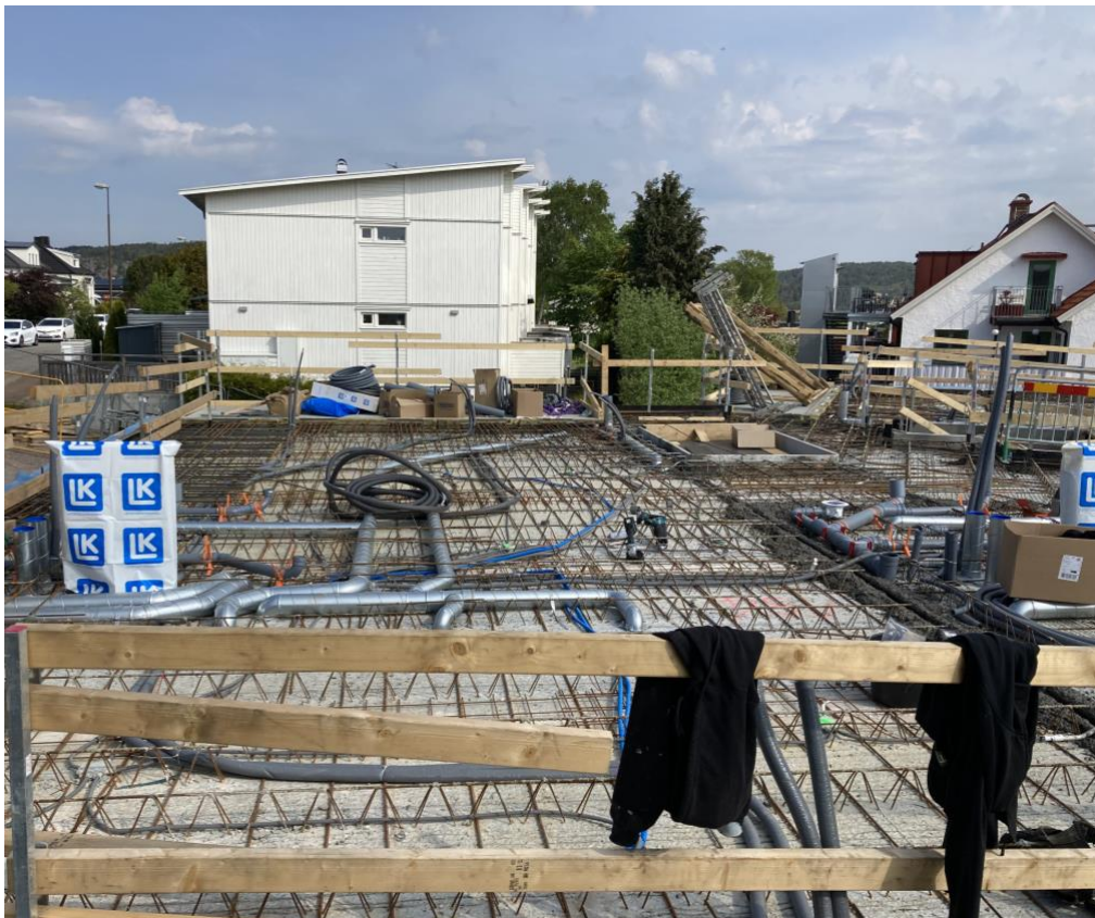
Bild 1. Platsgjuten stomme med armering och VVS. (Författarnas egen bild, 2022)
