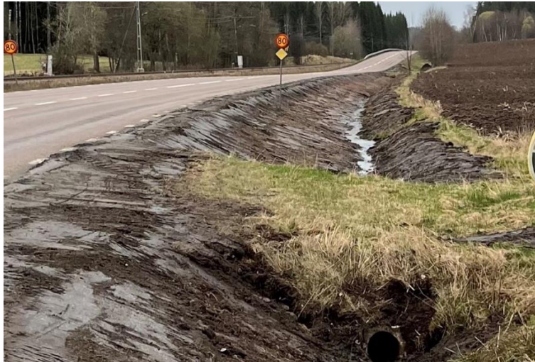
Figur 5. Resultatet efter utförd dikning, där massorna lagts i bakslänt.
