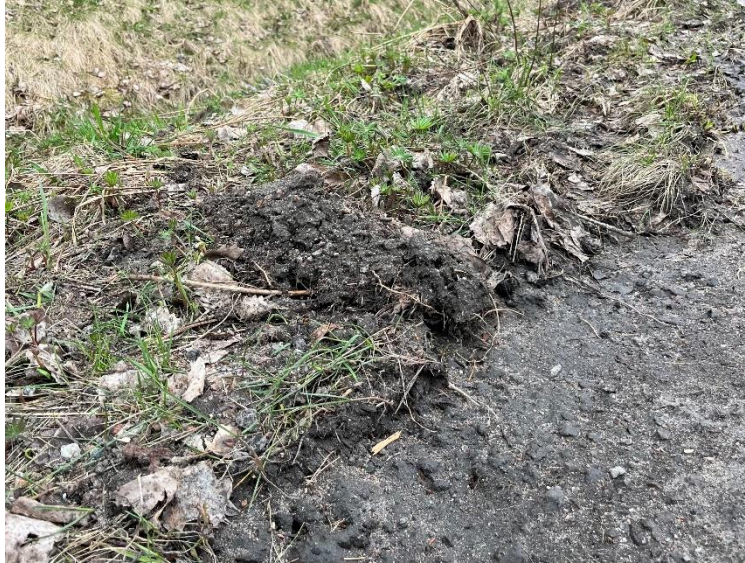
Figur 4. Kant mellan stödremsa och vägbana före dikning.
