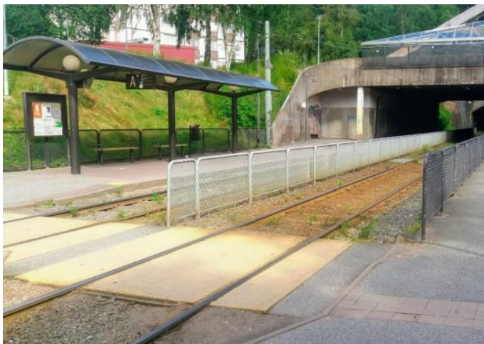
Bild 5: Avvikande färg i spåren (Källa: Tyréns, 2019).
