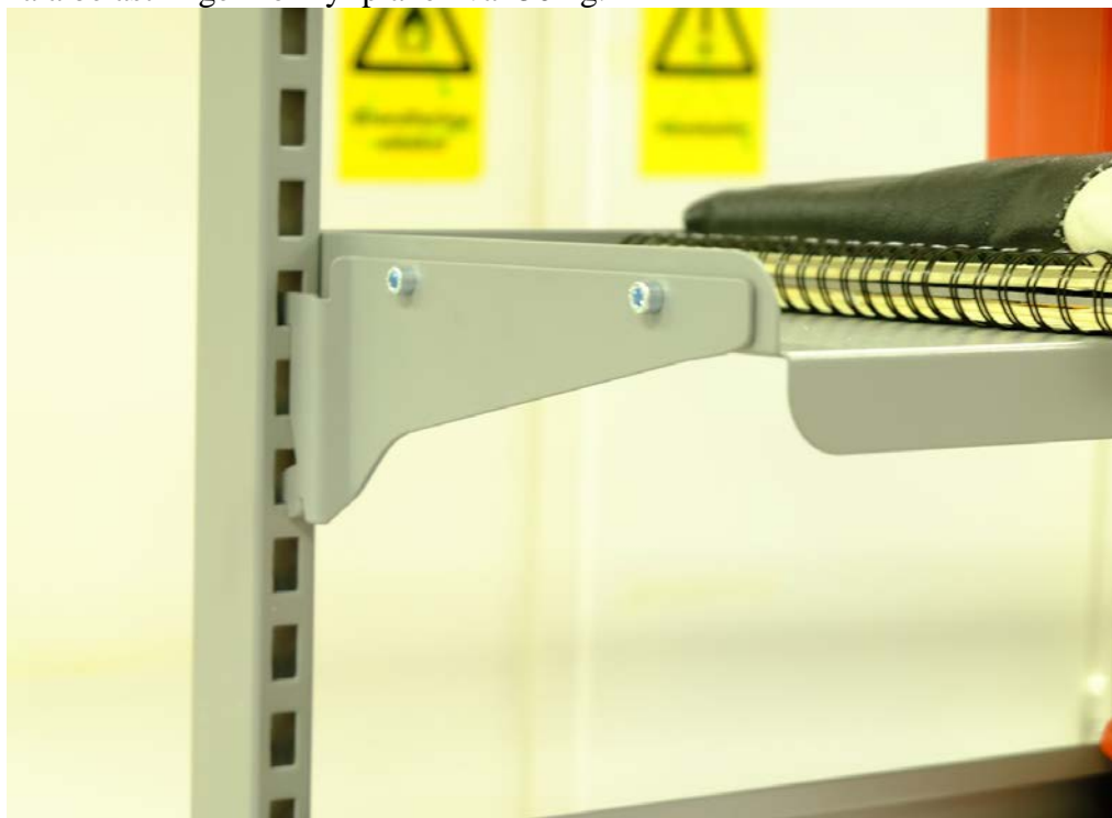
Figur 4.2 - WFI:s fäste för hyllor. En konsol fasthakad i en perforerad pelare, här i ett läge så att hyllplanet är horisontellt.
