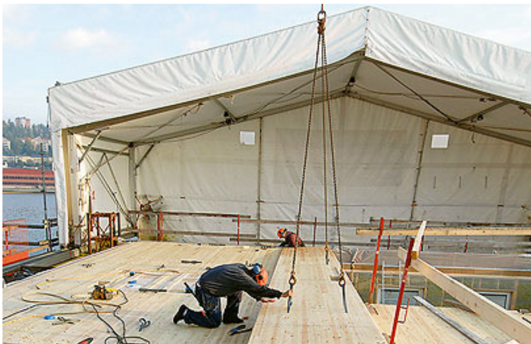
Figur 12 Prefabricerat träelement lyfts på plats, i bakgrunden syns ett väderskydd med flyttbara delar.(Martinsons trä, 2010)
