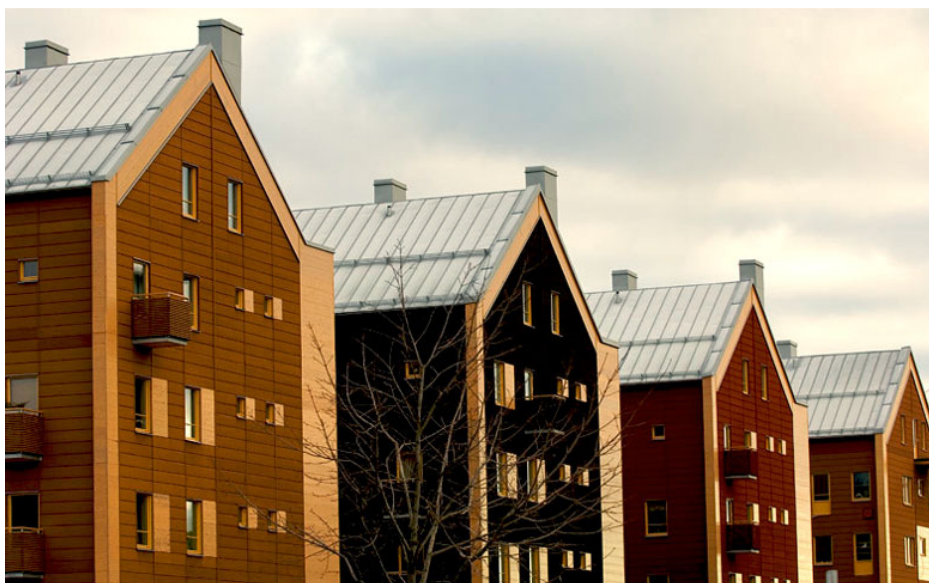
Figur 4 Kvarteret Inre Hamnen i Sundsvall, byggt med massivträteknik. (Svanthe Harström)
