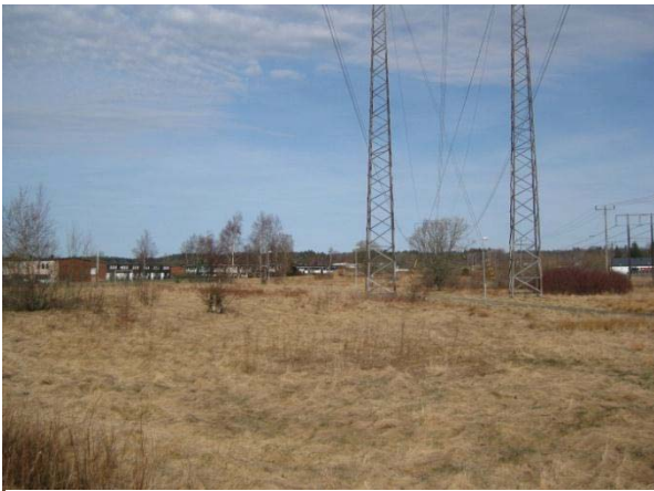
Figur 14: Kraftledningar i Gråbo, Foto 3.
