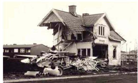
Figur 7: Rivning av stationshuset, ( www.lerum.se ).
