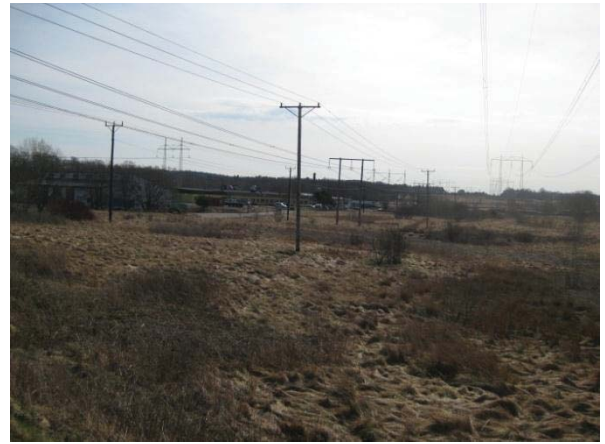
Figur 15: Kraftledningar i Gråbo, Foto 4.
