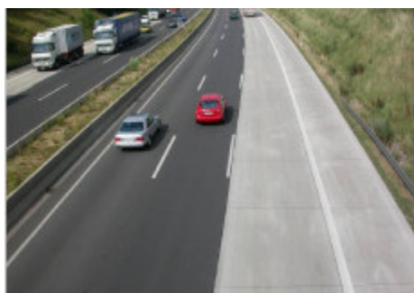
Figur 8.1 Kombinerad beläggning i Tyskland med betongbeläggning i det långsamgående körfältet samt vägrenen och asfaltbeläggning i de två snabbgående körfälten, Flies, Lundberg (2007).
