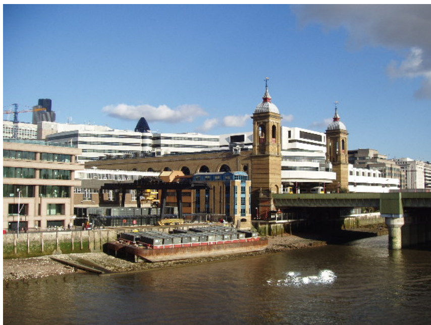
Figur 5: Walbrook Wharf Station med lyftkran och pråm.
