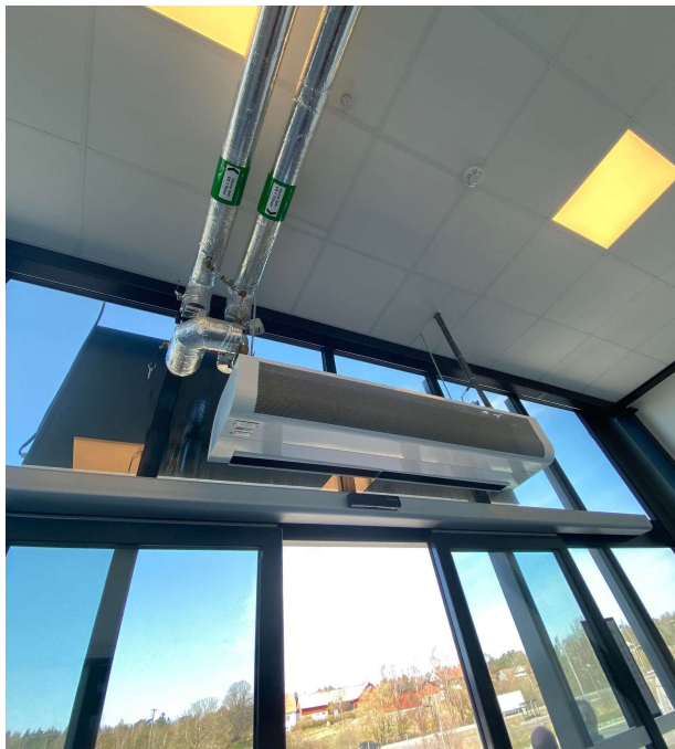
Figur 5.1 Ridåvärmare i Hisingen Logistikpark 2. (Författarnas egen figur)
