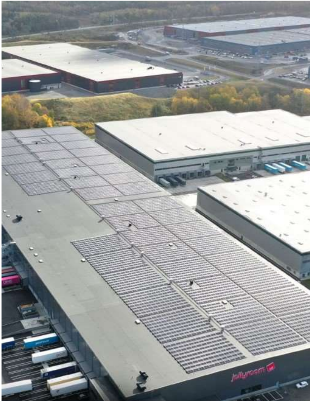
Figur 6.9 Solcellsanläggning på HLP2 (Castellum, 2021).
