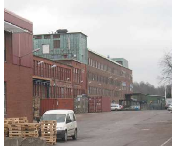
Fasaderna på S-fabriken (Svarv I-III) som ska rekonstrueras när ny handelsbyggnad uppförs. Fasaderna varierar samma tema: täta fönsterband med spröjsade fönster i röd tegelmur.
