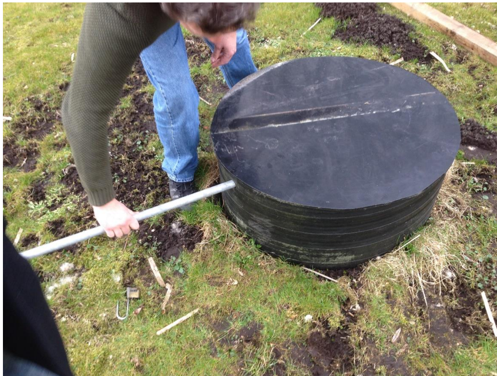
Figur 9. Stång som dras ut för att öppna brunnslöcket, Hässleholm.
