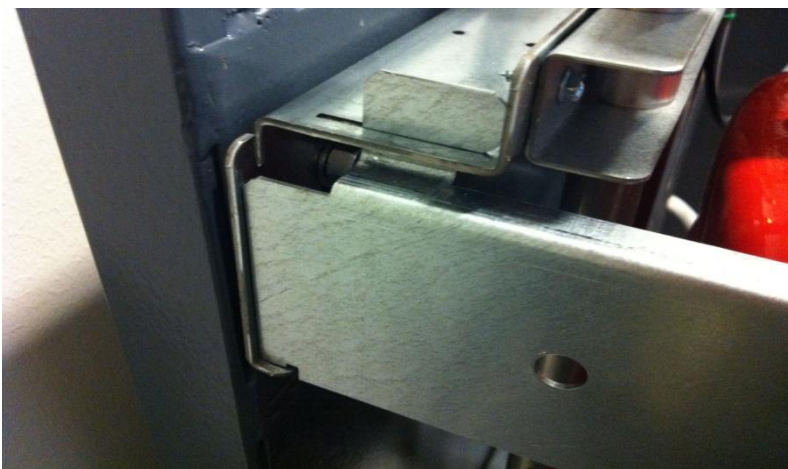
Figur 3.4 Balk monterad på ram
