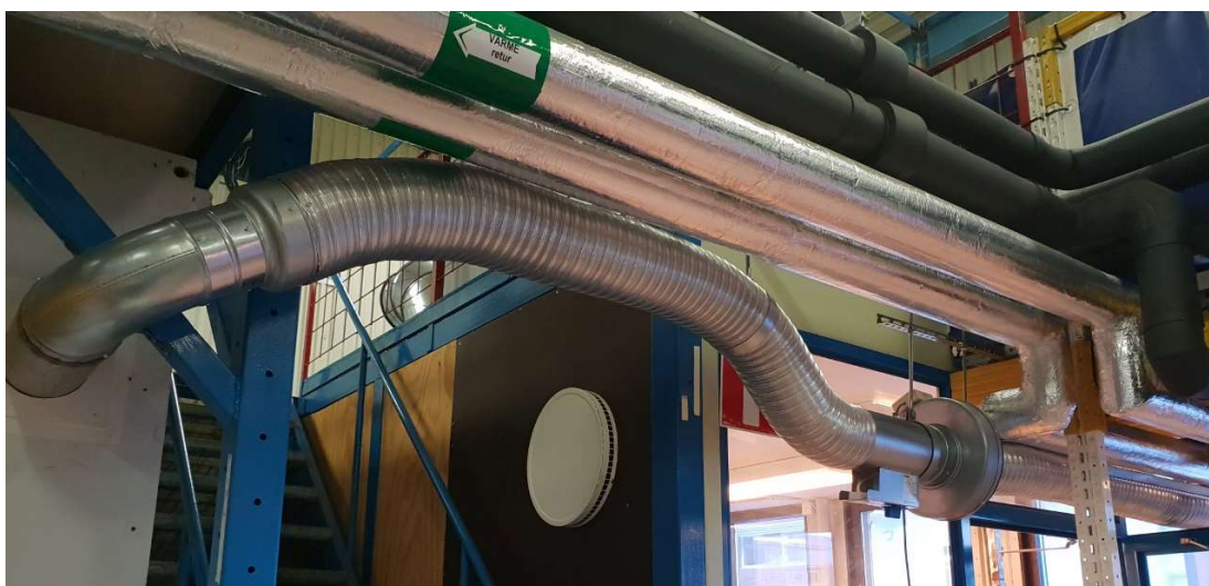
Bild 3.1 Ny kanaldragning av befintlig frånlufts kanal med tillhörande frånluftsfläkt.
