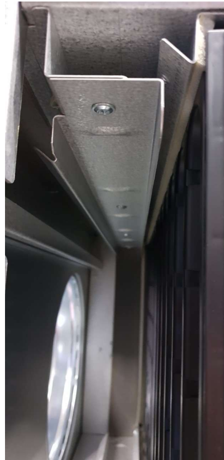
Bild 3.6 Plåtfästets nya position.
