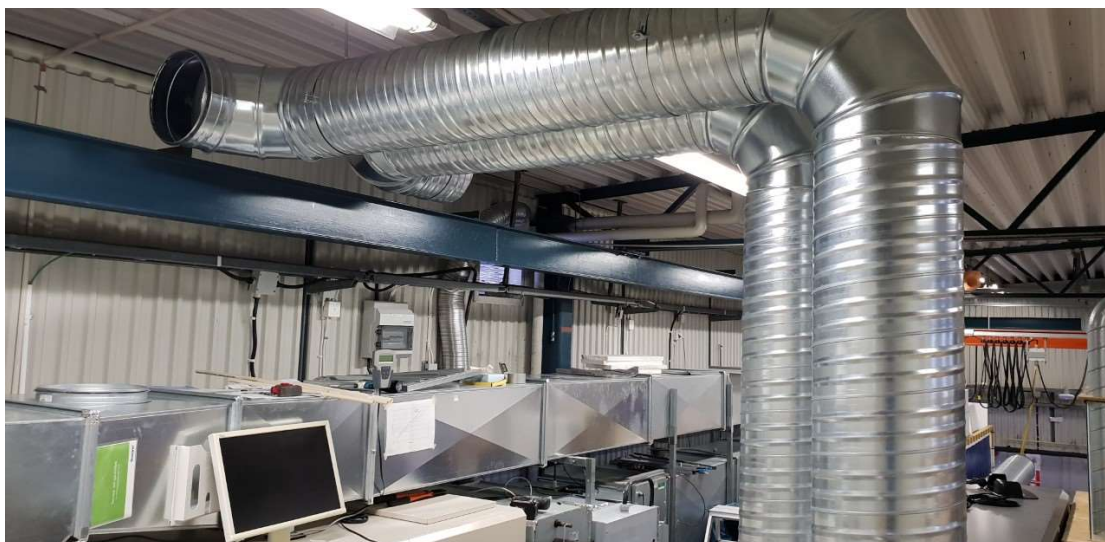
Bild 3.3 Av- och utluftskanal delvis monterade i takhöjd.
