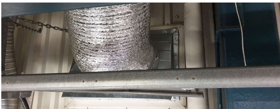
Bild 3.4 Avluftskanalens dimensionsövergång mot befintlig genomföring i klimatskal.
