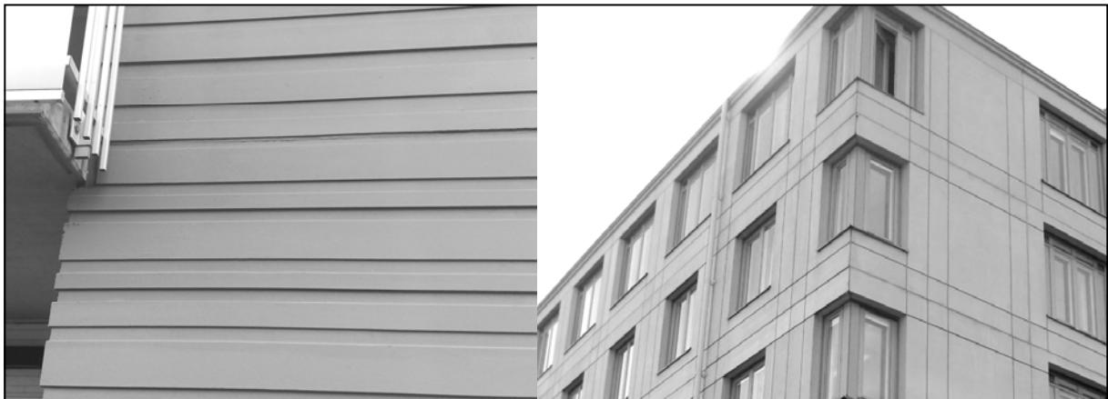
Figur 4.10 Till vänster: Dold horisontell fog i nivå med balkongplattan, Godhemsberget, Göteborg. Till höger: Linjespel med fogar, Polhemsplatsen, Göteborg. (Flodberg & Lundberg, 2007).
