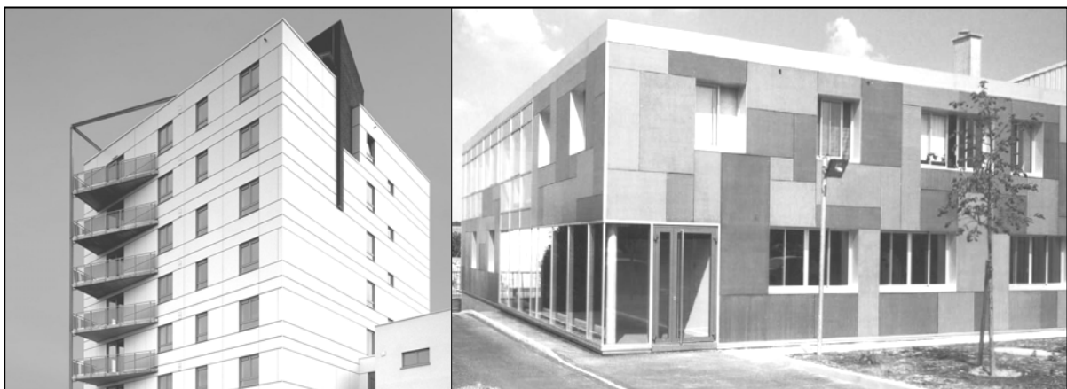
Figur 4.4 Flerbostadshus med skivelementfasader. Till vänster: Exempel på en fasadutformning som ger ett relativt vanligt utseende på byggnaden ( www.etermit.be ). Till höger: Fasaden på huset har getts en mer unik fasad med hjälp av variation i utseende på skivelementen ( www.ivarssonsverige.se ).
