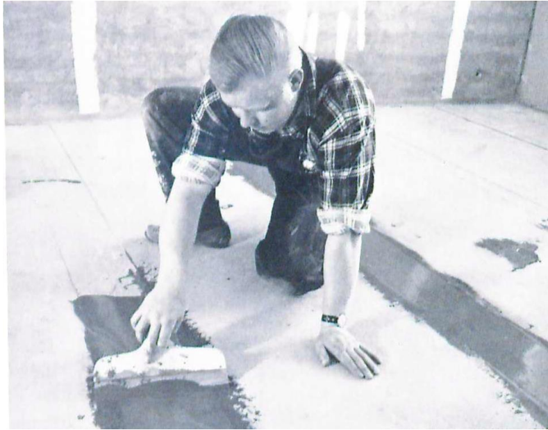
Figur 5: Spackling av fog mellan Nilconelementen
