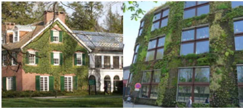
Figur 22. Exempel på en extensiv grön vägg till vänster och en intensiv grön vägg till höger (Breuning, 2014).
