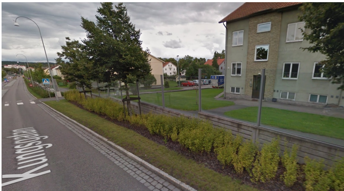
Figur 21. Exempel på genomskinlig bullerskärm i centrala Kungälv.
