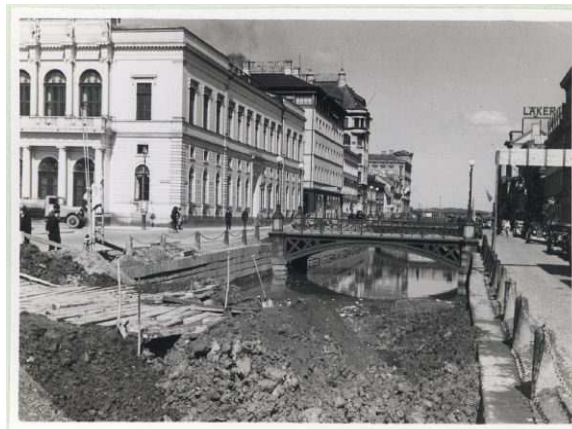
Bild 2: Utfyllnad av Östra Hamnkanalen
