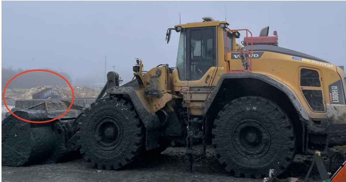
Figur 3. Hjullastare som sprider ut slam jämnt i en pool för en jämn fördelning inför vidare bearbetning.
