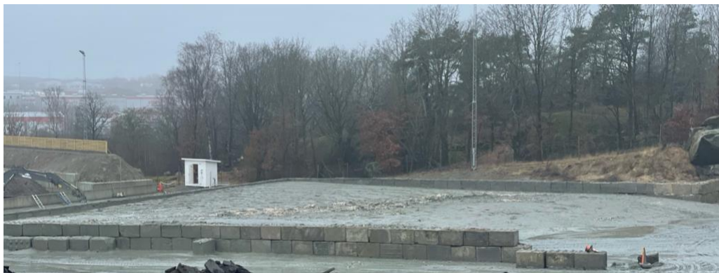
Figur 4. Uppfördelat slam i en pool efter spridning, vilket möjliggör en jämn och kontrollerad vidarebearbetning.
