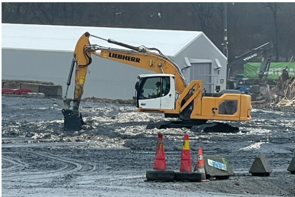
Figur 5. En grävmaskin som blandar sikt och annat relativt finfördelat material med slam och sediment i poolen för att skapa en blandning inför vidare transport till deponier.
