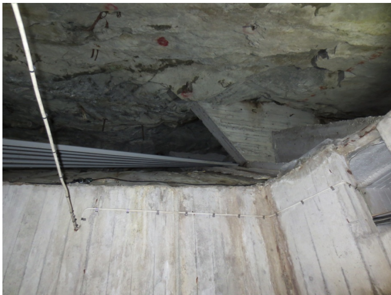
Figur 3.5 Gjutning mot berget.
