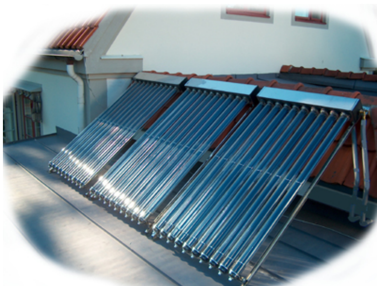
Figur 3.3 Vakuumsolfångare Exoheat ( www.exoheat.se )
