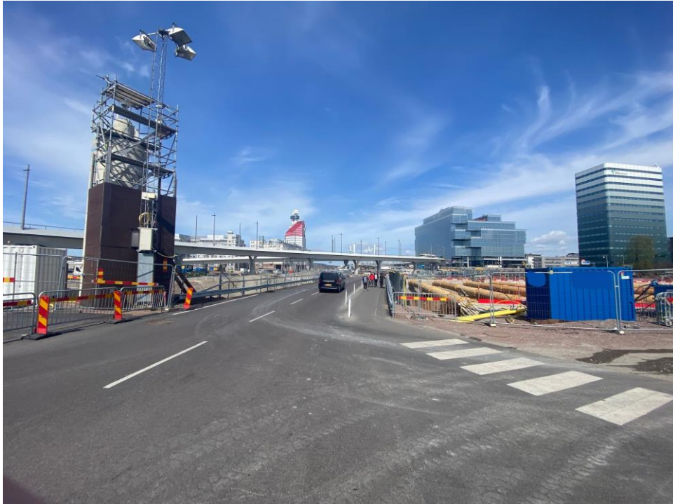
Figur 6. Bild på byggnation av Västlänken. På bild syns också (byggnader från vänster till höger) Läppstiftet, Platinan och Regionenshus. Tagen av författarna, riktning norrut.
