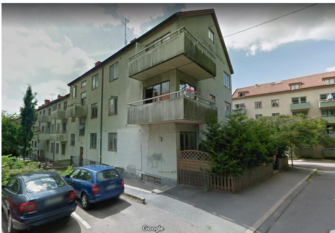
Figur 11: Projekt C före renoveringen som gjordes år 2013, fasad mot öst. Bild hämtad från Google Street View 2018, tagen 2011 (Google Maps, 2018d). Omarbetad.
