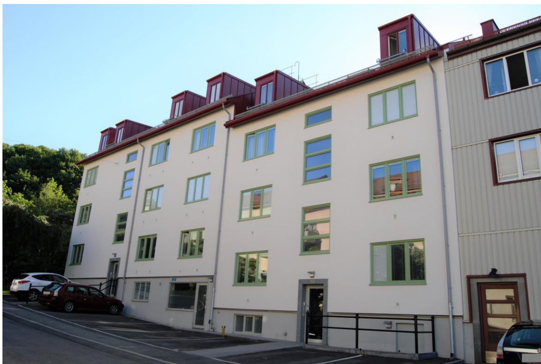
Figur 13: Projekt C efter renoveringen som gjordes år 2013, fasad mot väst. Bilden är tagen 2018. Författarnas egna bild.
