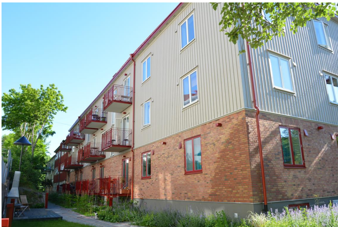
Figur 3: Projekt A efter om-renoveringen som gjordes år 2015, fasad mot väst. Bild tagen 2018. Författarnas egna bild.
