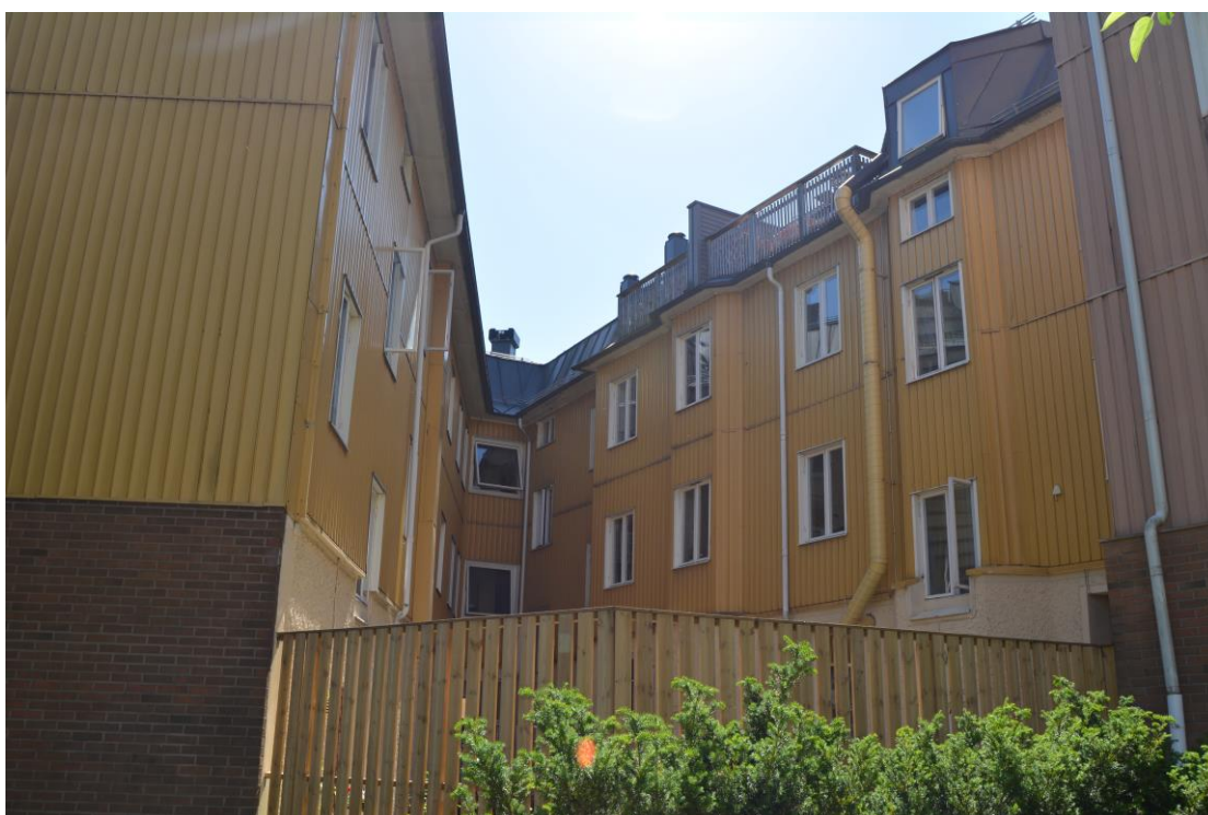
Figur 8: Projekt B efter om-renoveringen som gjordes år 2010, fasader in mot gård som ännu är klädda med plåt. Bild tagen 2018. Författarnas egna bild.
