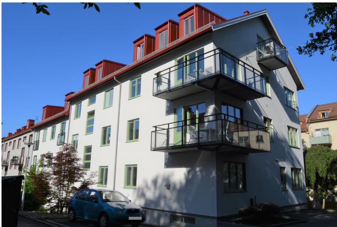
Figur 14: Projekt C efter renoveringen som gjordes år 2013, fasad mot öst. Bilden är tagen 2018. Författarnas egna bild.
