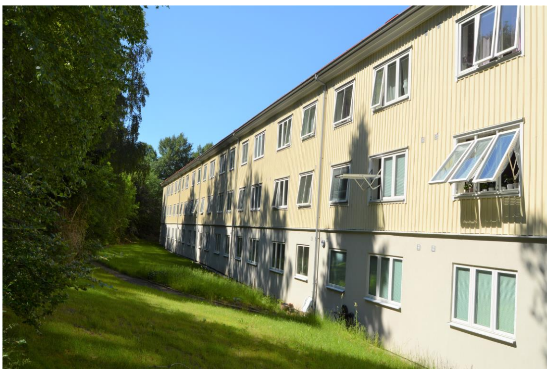
Figur 19: Projekt D efter om-renoveringen som gjordes år 2015, fasad mot sydöst Bilden är tagen 2018. Författarnas egna bild.
