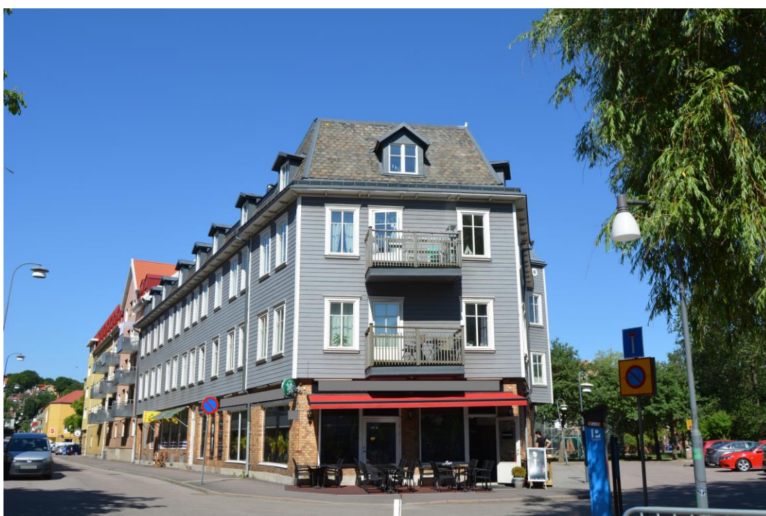
Figur 6: Projekt B efter om-renoveringen som gjordes år 2010, hörnfasad mot gatan. Bild tagen 2018. Författarnas egna bild.
