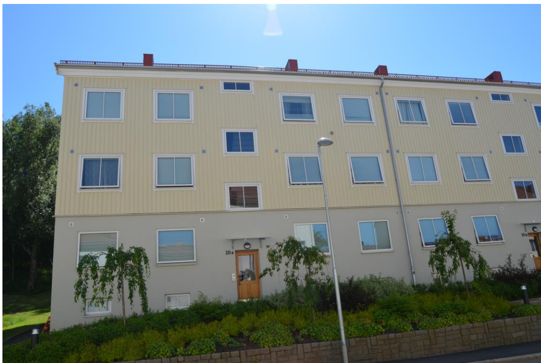
Figur 18: Projekt D efter om-renoveringen som gjordes år 2015, fasad mot nordväst Bilden är tagen 2018. Författarnas egna bild.
