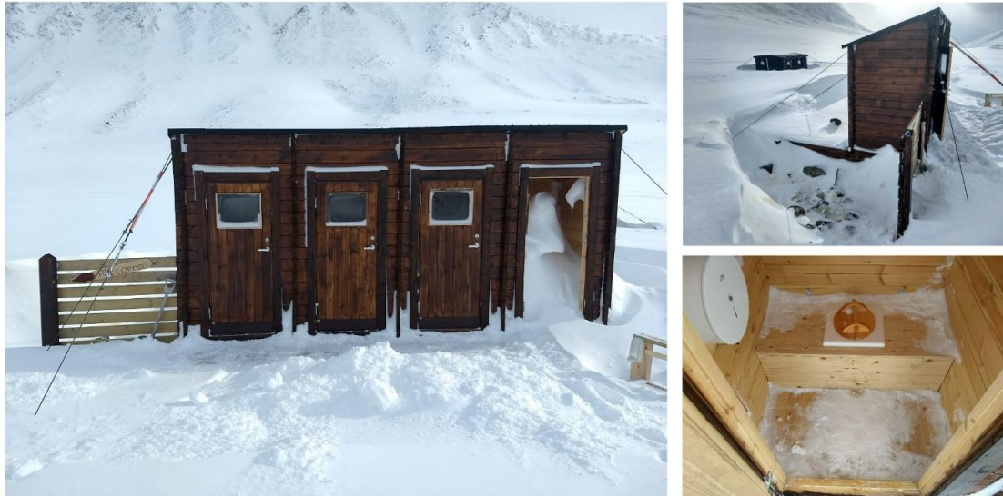
Figur 12 Bilder från mars 2019 på den nya storgropstoaletten i Tarfala. Det har blåst och snö har drivit in i båset. Överbyggnaden är ordentligt fäst i marken med vajer. Skylten vid staketet uppmanar till att använda "kisshörnet". Fotograf: Pontus Göransson.
