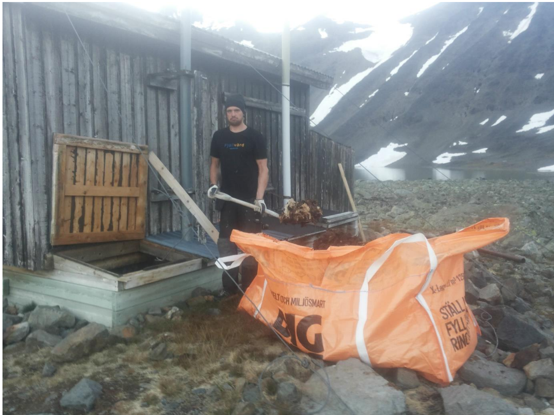
Figur 9 Försök till tömning av torrtoalett av typ storgrop vid STF:s stugplats i Tarfala i Kebnekaise fjällen i september 2015. Foto: Erik Nyström
