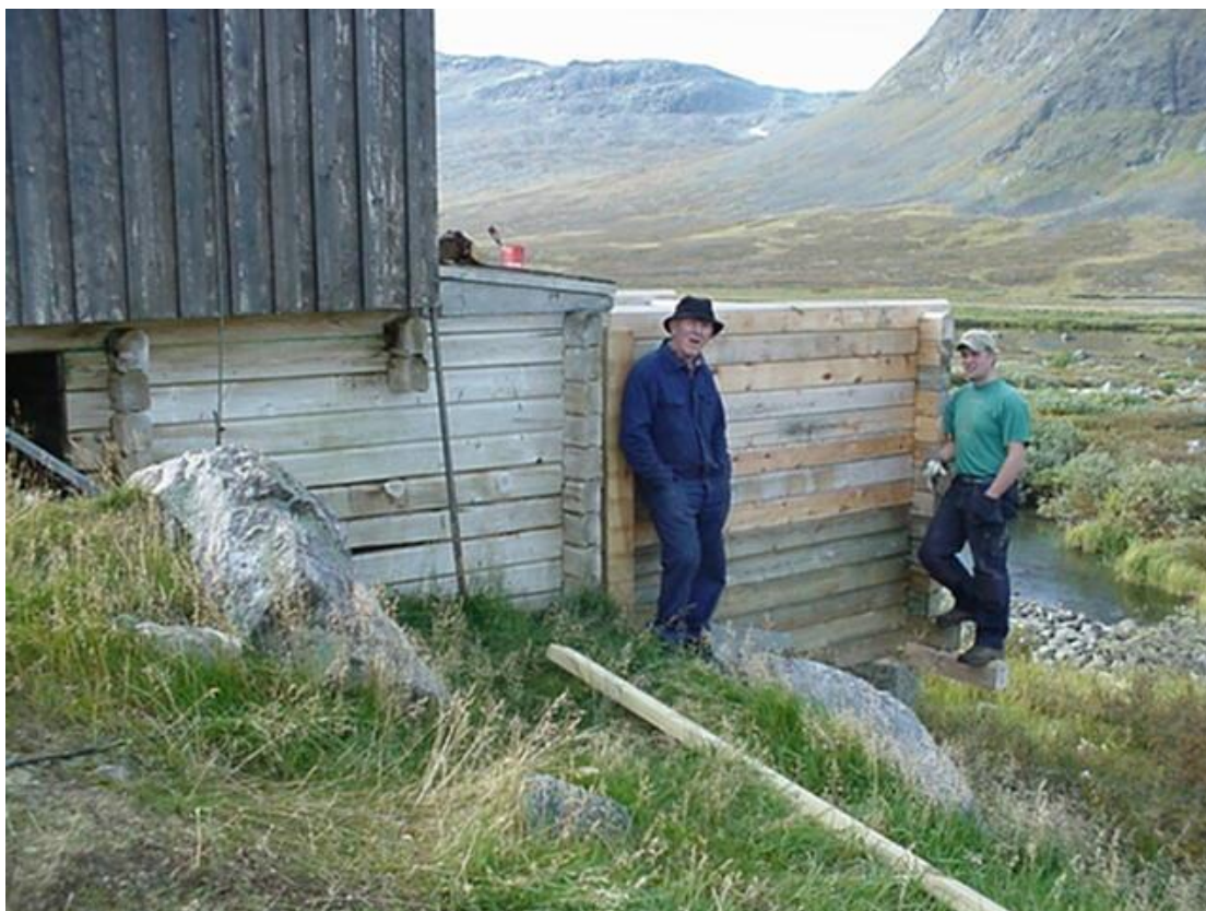
Figur 10 Toalett vid STF:s Singi-stuga, där timmertanken just förlängts i bakkant. Foto: Birger Dynesius
