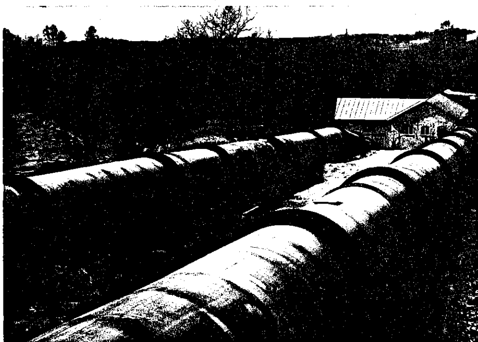
Bild 3. Tilloppstuberna vid Kungsfors kraftstation.
