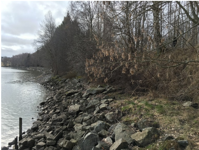
Figur 2.8 Erosionsskydd i strandkanten av slänten i sektion 32/760 (Bild tagen av författarna).
