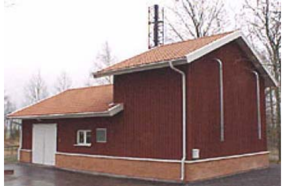
Figur 7. Närvärmecentral i Lidköpings kommun, (ÄFAB, 2006)
