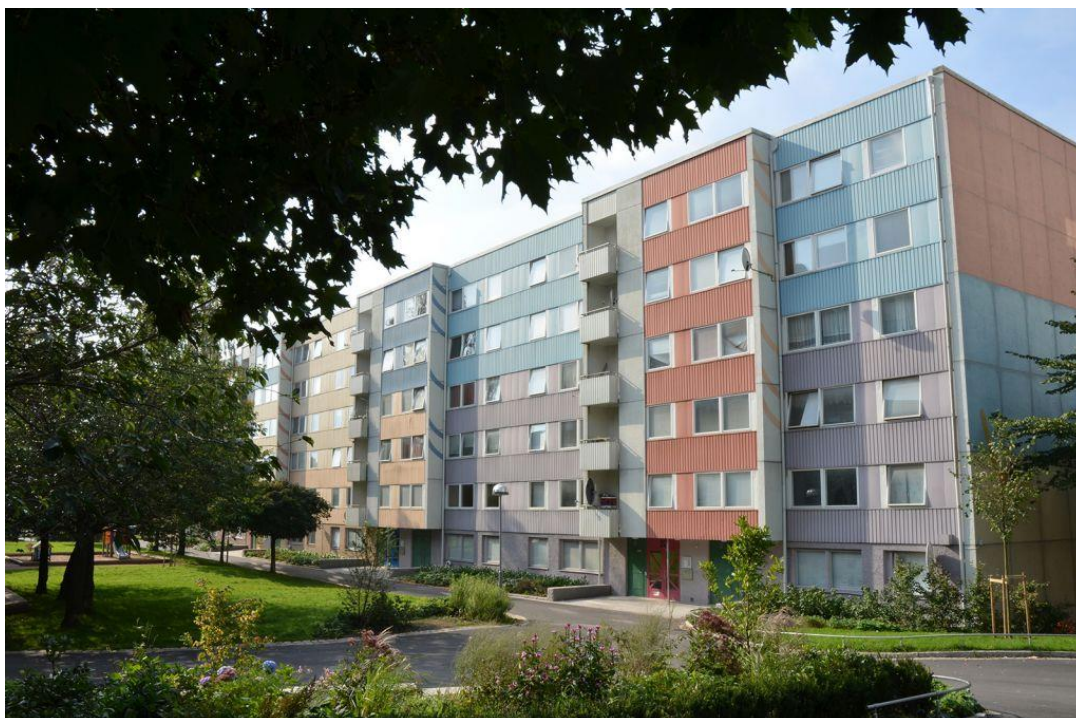
Figur 2. Överskådlig bild på en del av byggnaden (Källa: Familjebostäder AB i Göteborg)
