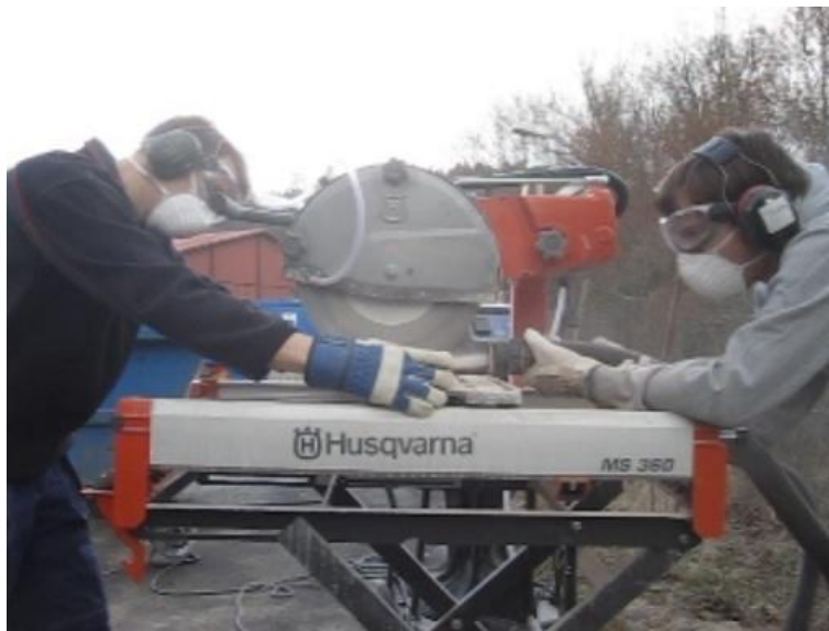
Figur 8.1 – Dammuppsamling med dammsugare i "perfekt" höjd
