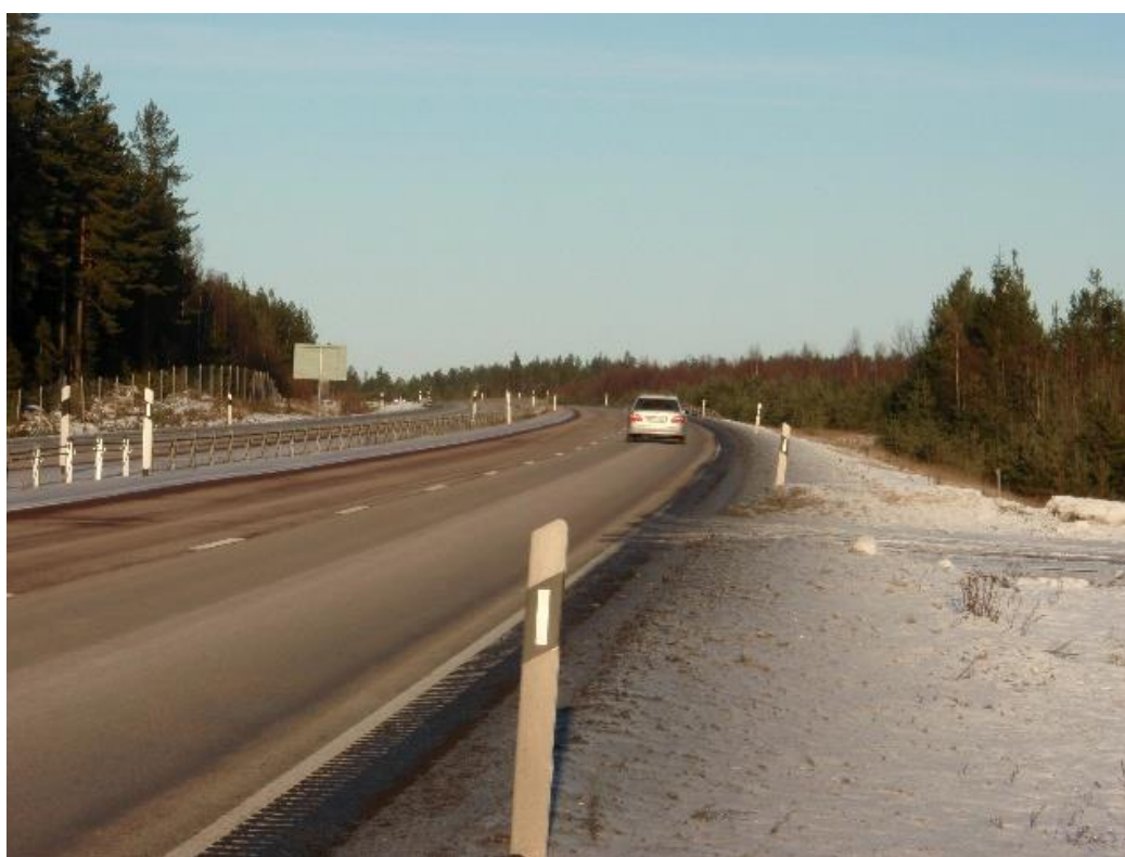
Figur 5.2 Kurva på E4:an med negativt tvärfall
